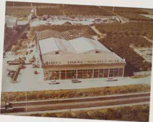
Construcción de la ampliación de la fábrica
