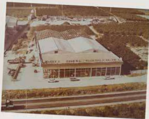
Construcción de la ampliación de la fábrica
